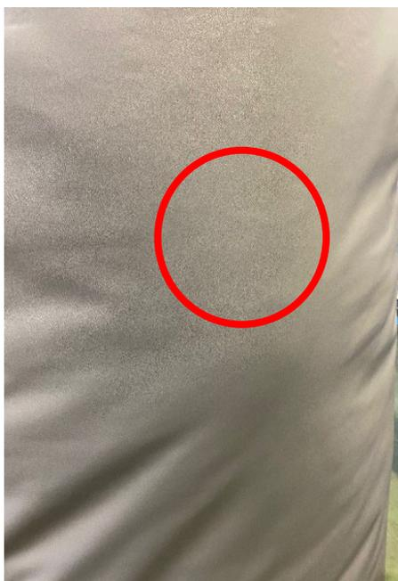
Identifier la position des piquages en appuyant manuellement sur l'isolant.
