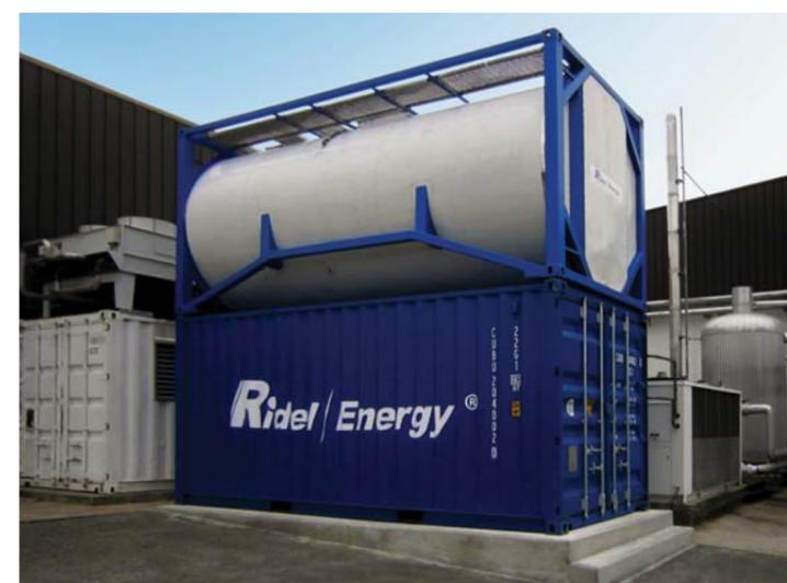
Après l'installation d'un Ridel/Cub au lieu d'utiliser une eau à 10-12°C, nous alimentons avec de l'eau préchauffée à 50°C. Nous ne chauffons plus de 10 à 65°C mais de 50 à 65°C
