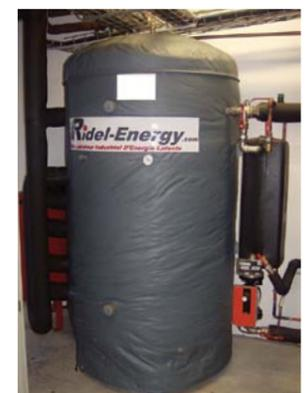
**LE BALLON DE STOCKAGE PERMET DE DIFFÉRER LA PRODUCTION DE FROID DE LA CONSOMMATION D'EAU CHAUDE.**
